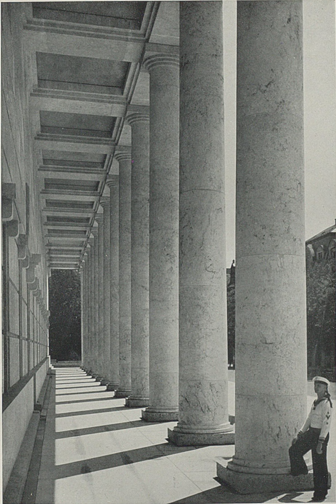
„Haus der Deutschen Kunst.“ Der Säulengang auf der Südseite. Architekt Professor Paul Ludwig Troost f
