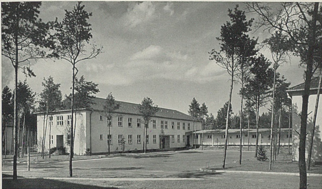
Flakabteilung; Mannschaftsunterkünfte. Rauher Spritzwurf, Dachneigung 30%. Fenster 6 cm hinter Putzvorderkante, Eingang u. Stützenverkleidung aus Muschelkalk, Sockel in gelbbraunen Siegersdorfer Platten
