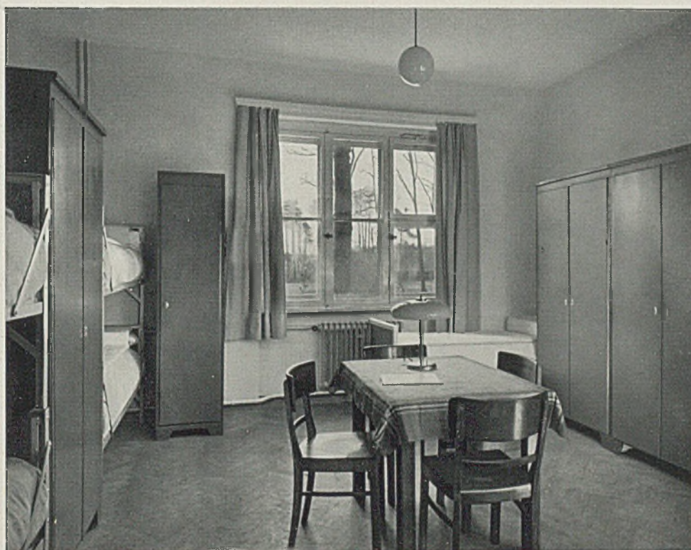
Innenansicht einer Mannschaftsstube für vier Mann mit 24 qm Fläche. Kalkfarbenanstrich, Stabfußboden in geöltem Buchenholz, Einheitsschränke 1 m breit, Doppelfenster mit Lüftungsflügel; Heizungsleitungen auf Putz
