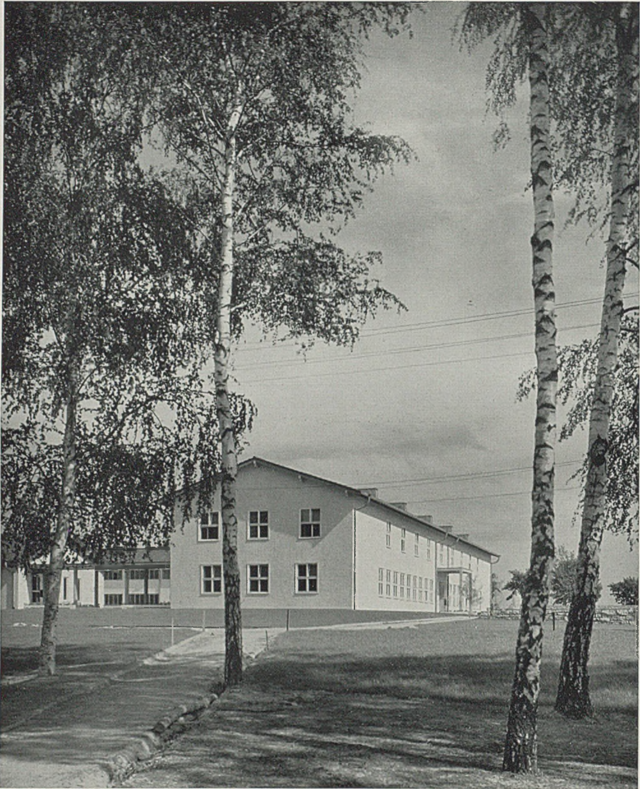
Stabsgebäude. Einfacher Putzbau mit vorgesetzten Fenstern und etwas vorstehendem, flachgeneigtem Dach
