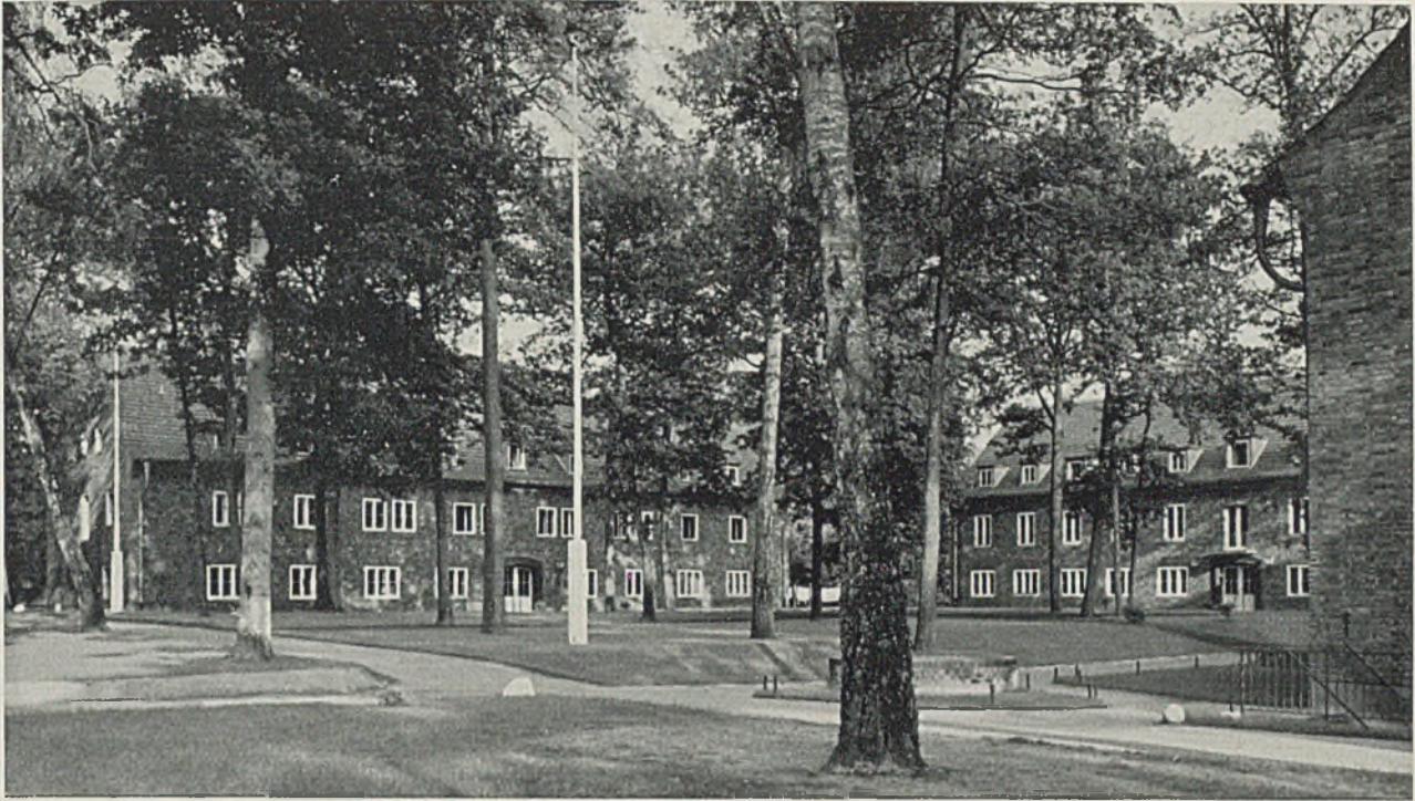
Mannschaftsunterkünfte beim Flughafen. Ziegelrohbau mit Biberschwanzdach, Sockel in Beton
