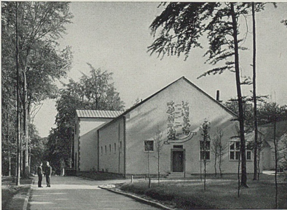
Wirtschaftsgebäude mit Bemalung des Giebfeldes über der Eingangstüre. Altdeutscher Scheibenputz, Pfannendeckung; Werksteineinfassungen und Sockel in rotem Sandstein
