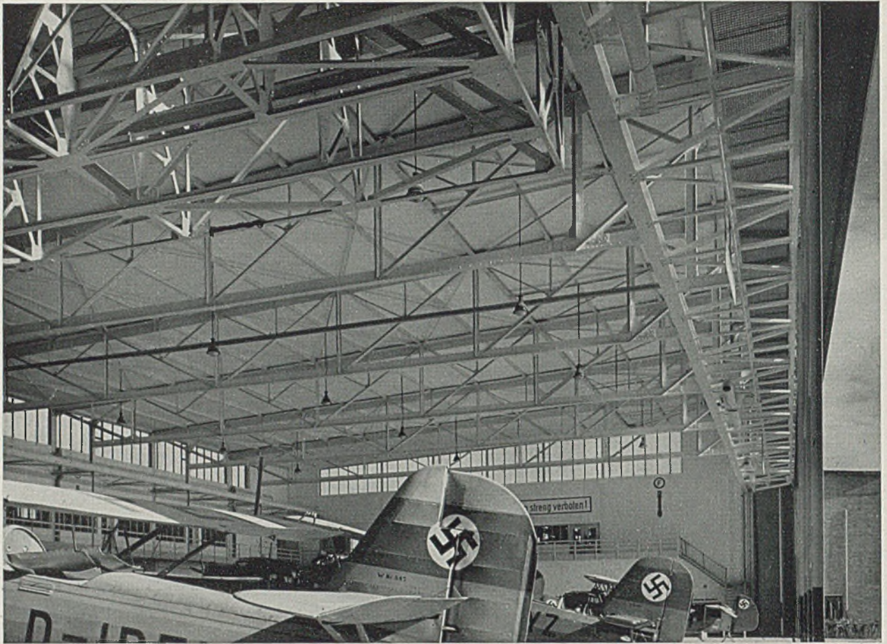
Eiserne Fachwerkkonstruktion mit Sammelträger und Zwischenstütze. Stellfläche: 50 × 40 m.
