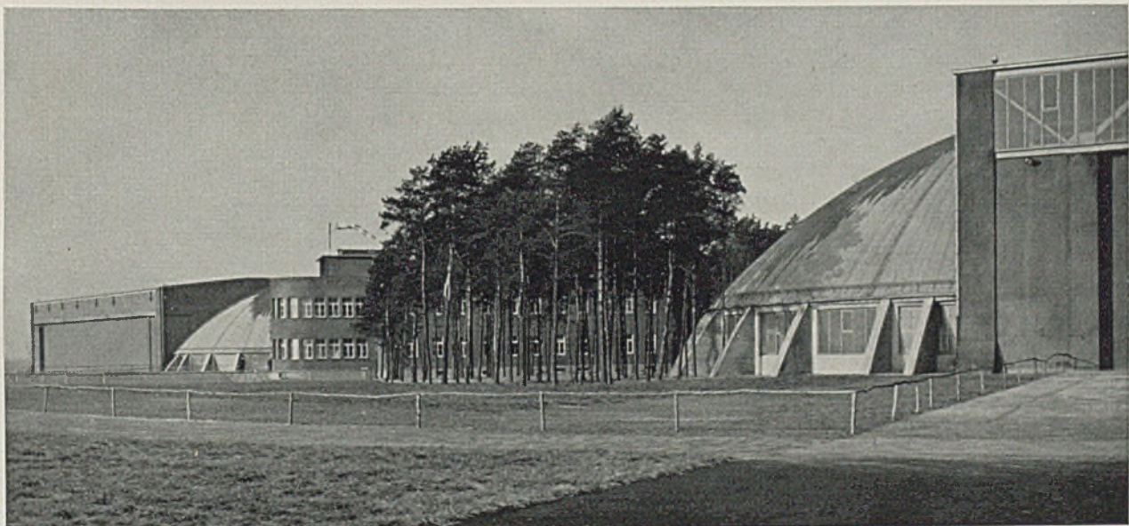
Stahllamellenhalle mit eigenem räumlichem Fachwerkträger in Torebene. Keine Zwischenstütze. Seitliche Kuppeln.
