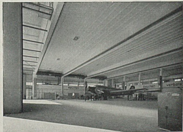
Links: Vollwandige Rahmenkonstruktion in Stahl (geschweißte Rahmenbinder). Die Hauptträger sind parallel zur Toröffnung ohne Zwischenstützen angeordnet. Stellfläche 50 × 35 m, Torhöhe 4,50 m. Rechts: Werft in eiserner Fachwerk-konstruktion mit parallel geführten Bindern ohne Zwischenstützen. Stellfläche 50 zu 40 m.
