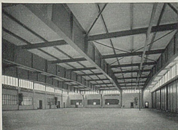
Links: Vollwandige Rahmenkonstruktion in Stahl (geschweißte Rahmenbinder). Die Hauptträger sind parallel zur Toröffnung ohne Zwischenstützen angeordnet. Stellfläche 50 × 35 m, Torhöhe 4,50 m. Rechts: Werft in eiserner Fachwerk-konstruktion mit parallel geführten Bindern ohne Zwischenstützen. Stellfläche 50 zu 40 m.
