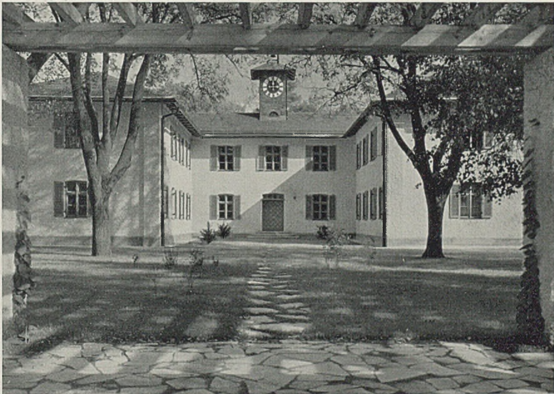
Umbau einer alten Kaserne zu einer Offiziersunterkunft. Dachdeckung: graublauer Schiefer in deutscher Deckung. Putz in Kellenwurf. Sparrengesims
