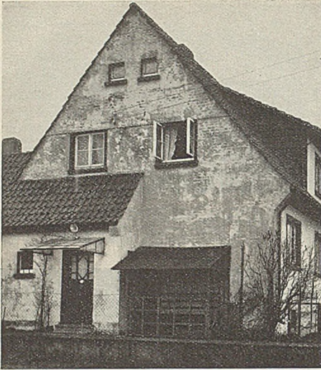
Abbildung 12. Putzschlümme ist nicht am Platze, wo das Klima selbst den festen Putz derartig mitnimmt!
