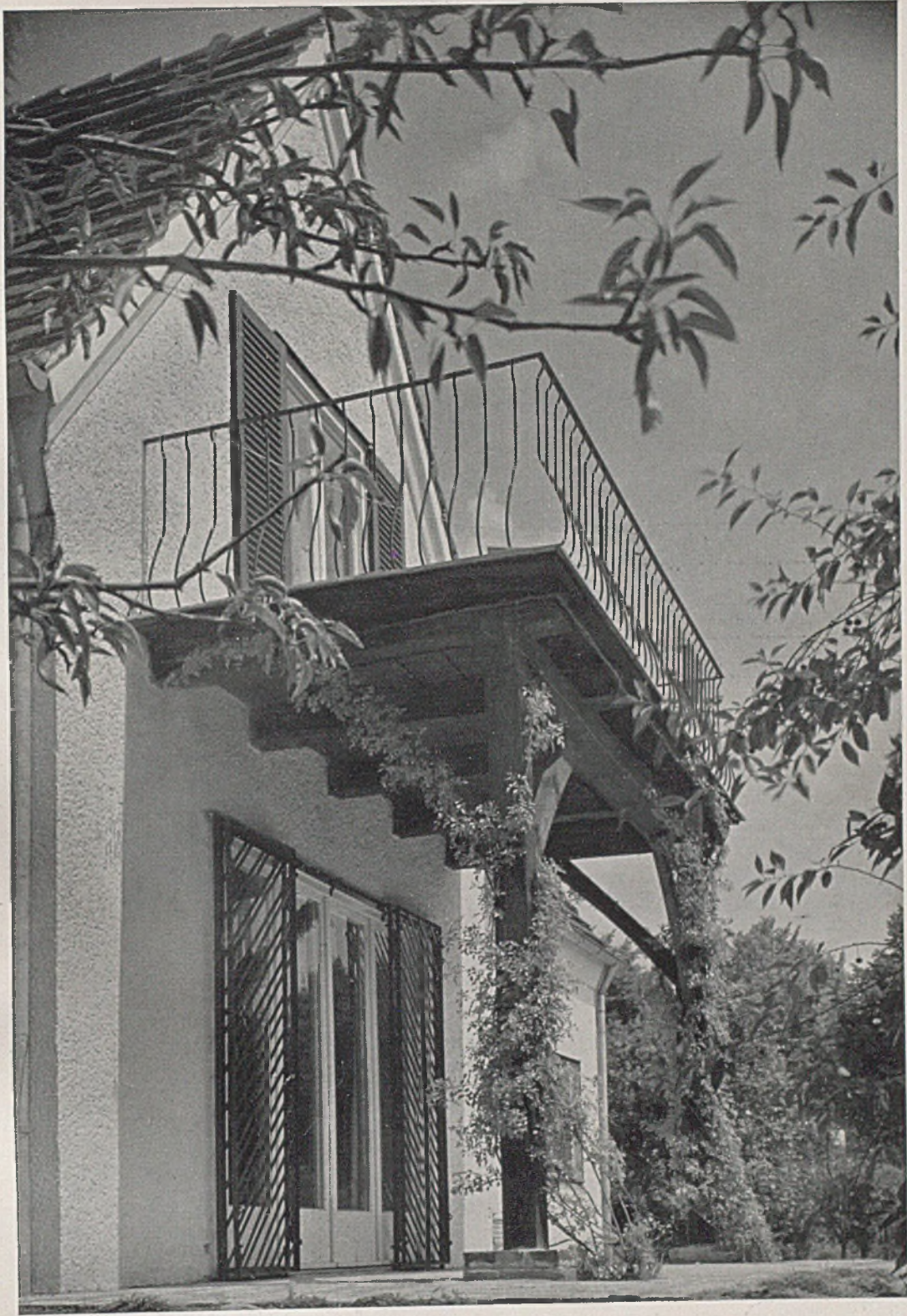
Haus K. in Berlin-Schmargendorf. Architekt Herbert Noth-Berlin. Südseite, Giebelbalkon in Holz mit schmiedeeisernem Geländer
