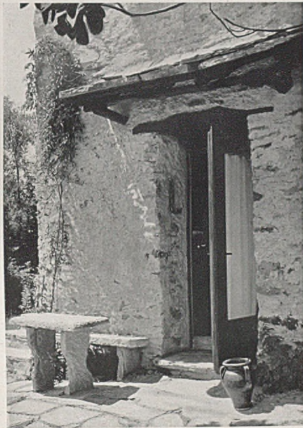
Kleines Tessiner Ferienhaus. Oben: Treppenweg zu dem tief unter der Fahrstraße lie- genden Haus. An der Mauer ist noch die ursprüngliche Tessiner Weinbergterrasse zu erkennen.— Unten: Der Sitz-
