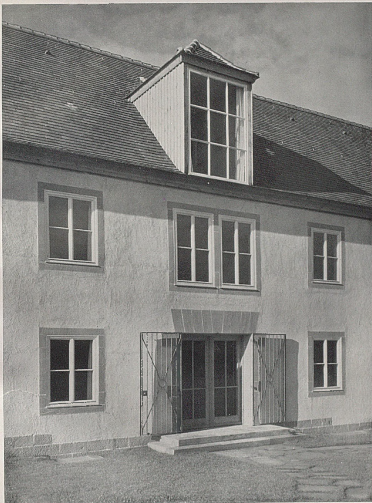
Neubau der Bausparkasse Leonberg. Nordseite mit Ausgang zum Garten, Hallenfenster im Obergeschoß und Atelierfenster im Dachgeschoß. Nahaufnahme mit Materialwirkung
