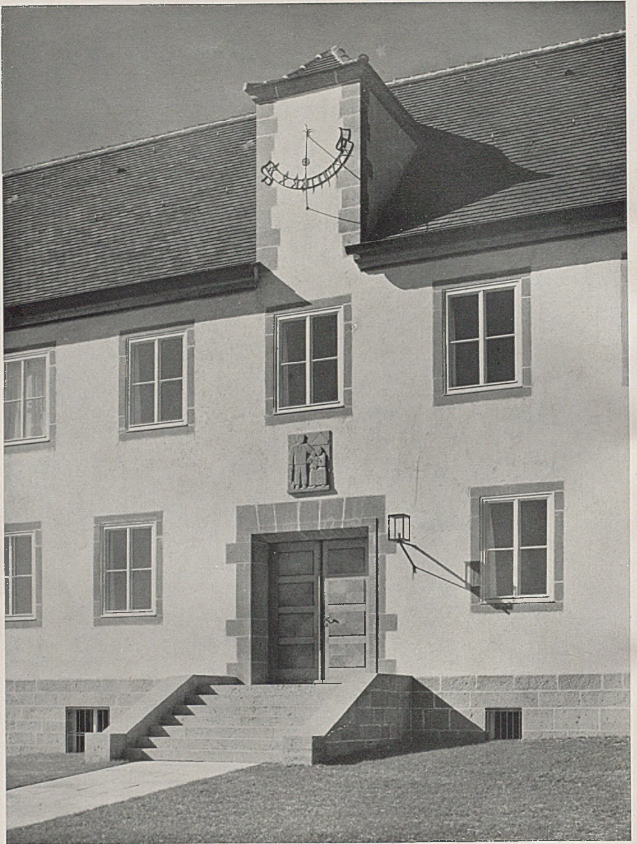
Haupteingang der Leonberger Bausparkasse mit Hausteinumrahmung. Architekt Professor Willem Bäumer-Weimar
