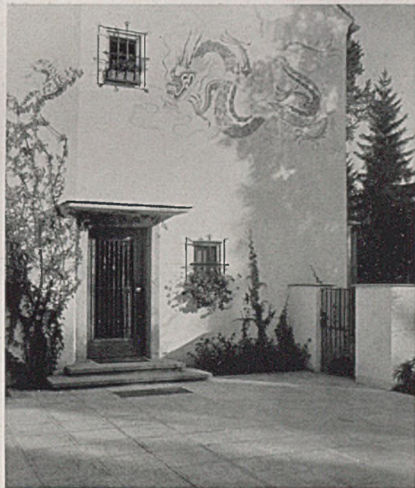
Der Eingang mit bewegter Wandmalerei, einen fauchenden Drachen darstellend (in Erinnerung des Bauherrn an seinen langjährigen Aufenthalt in China)
