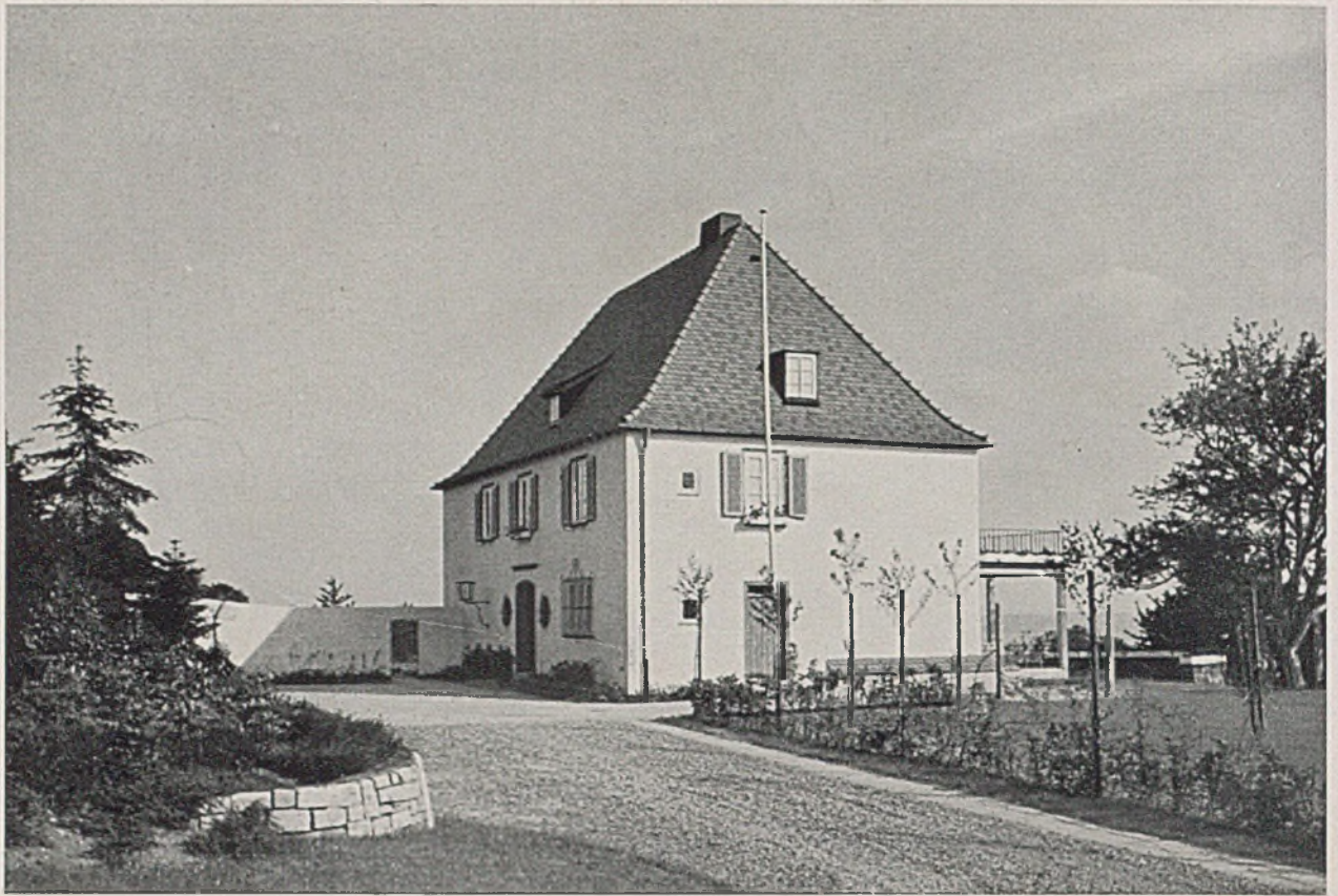
Wohnhaus in Frankenholz auf dem Höcherberg im Saarland. Architekt Rudolf Krüger - Saarbrücken
