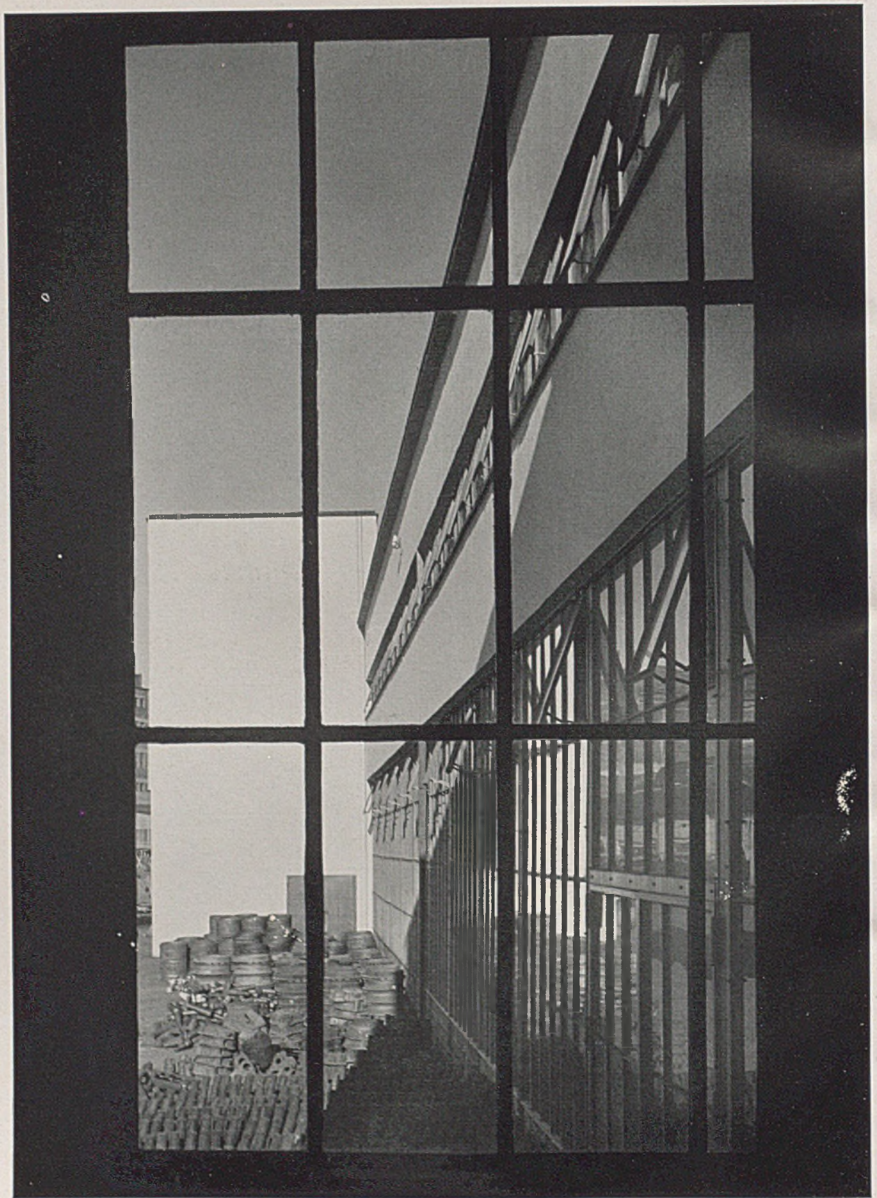
Hallenbau am Osterdeich, Hofseite; Blick aus einem Treppenhaus.
