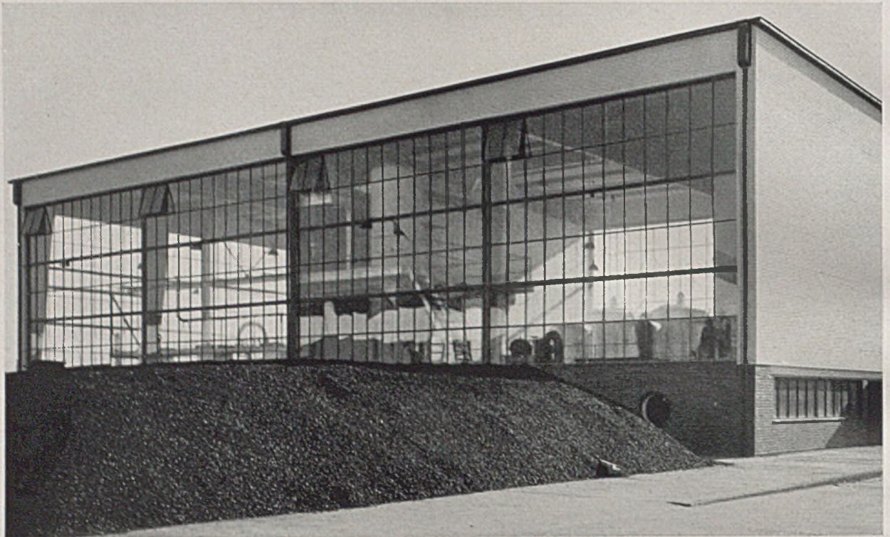
Das Kesselhaus der neuen Werkanlage mit darunter gelegenem Kokskeller und Nebenräumen für Pumpen u. and. m.
