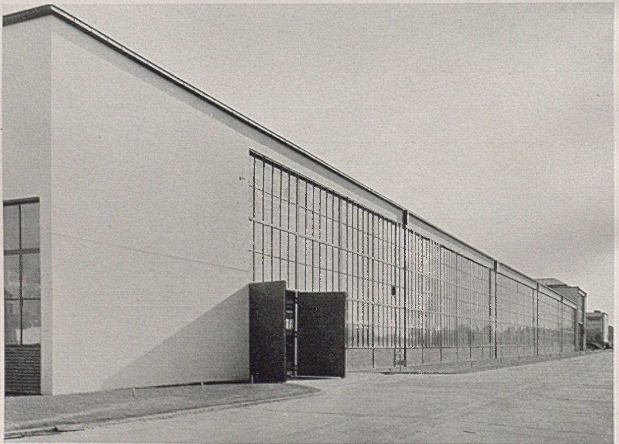
Eine der vorerwähnten 15 Querhallen von 120 m Länge, die im Süden gegen die höhere Eisenbahnlängshalle stößt.
