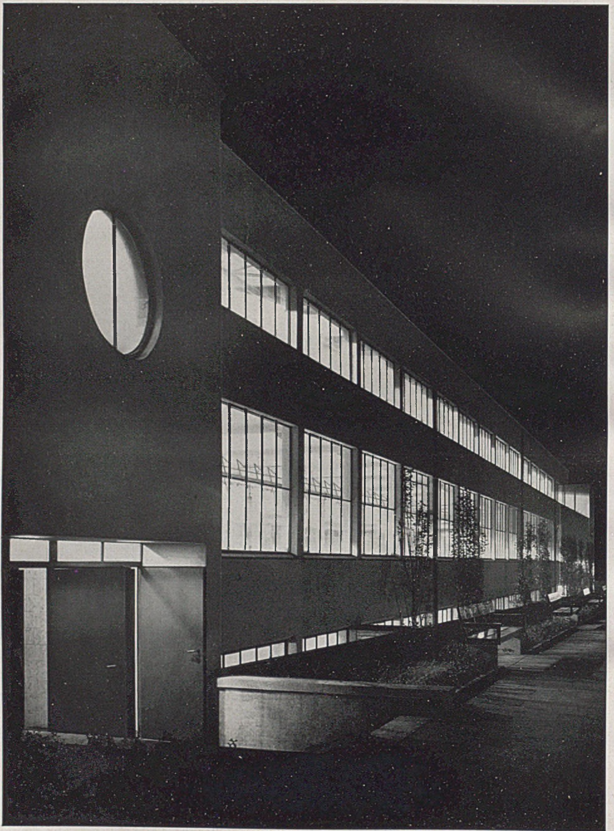
Motorenhalle am Rosenberg. Nachtaufnahme bei vollem Werkbetrieb
