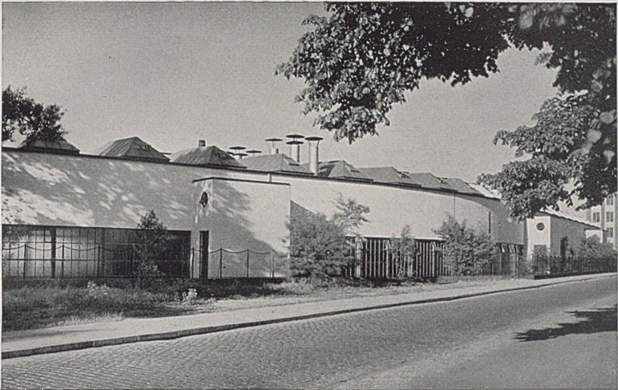
Hallenbau am Osterdeich mit Südseite nach der Straße am Osterdeich. Die Seitenwände im Obergeschoß sind durchwegs fensterlos ausgebildet im Hinblick auf die durchlaufenden Raupenoberlichte. Zwischen den Oberlichtern sind Entlüfter für die Spritzkabinen angeordnet
