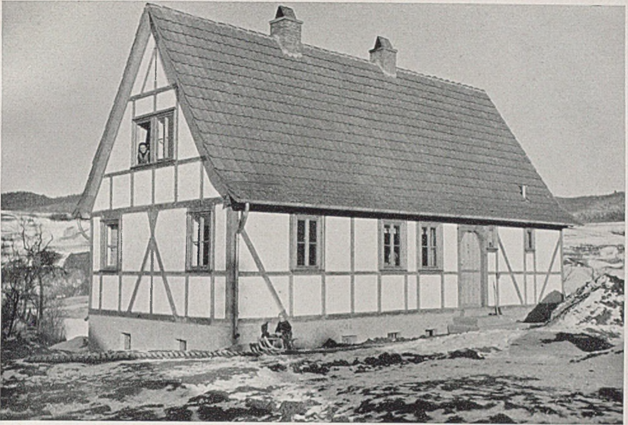
Soeben fertiggestellte Siedlerstelle in Fachwerkbau. Holz mit Xylamon ohne Farbzusatz gestrichen, Schreinerwerk nur geölt
