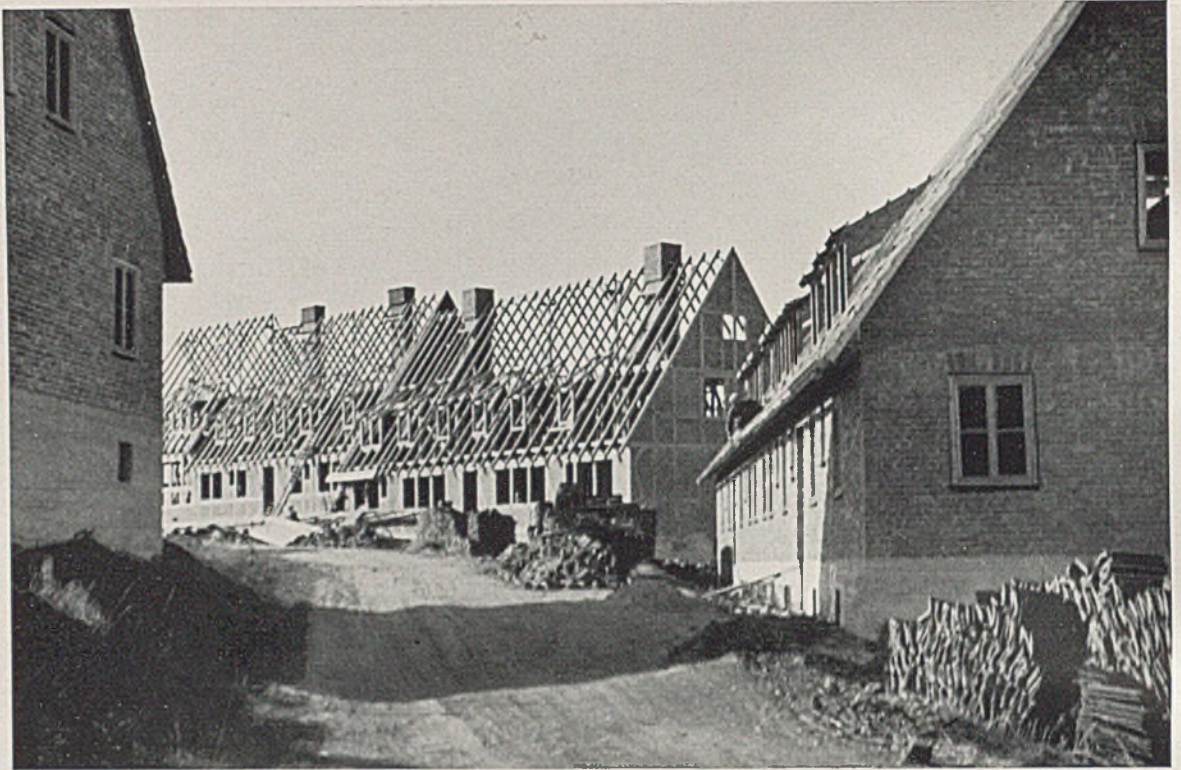
Siedlungsabschnitt Sontra I. Ausschnitt aus einem Straßenraum während des Rohbaues
