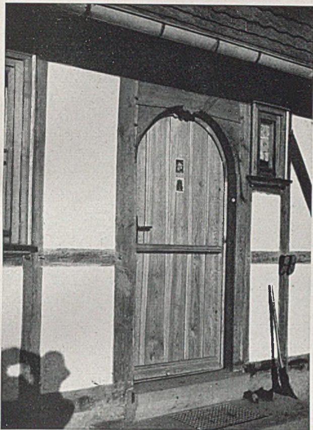
Haustüre einer neuen Siedlerstelle; rechts das Holzfachwerk kurz nach der Aufstellung
