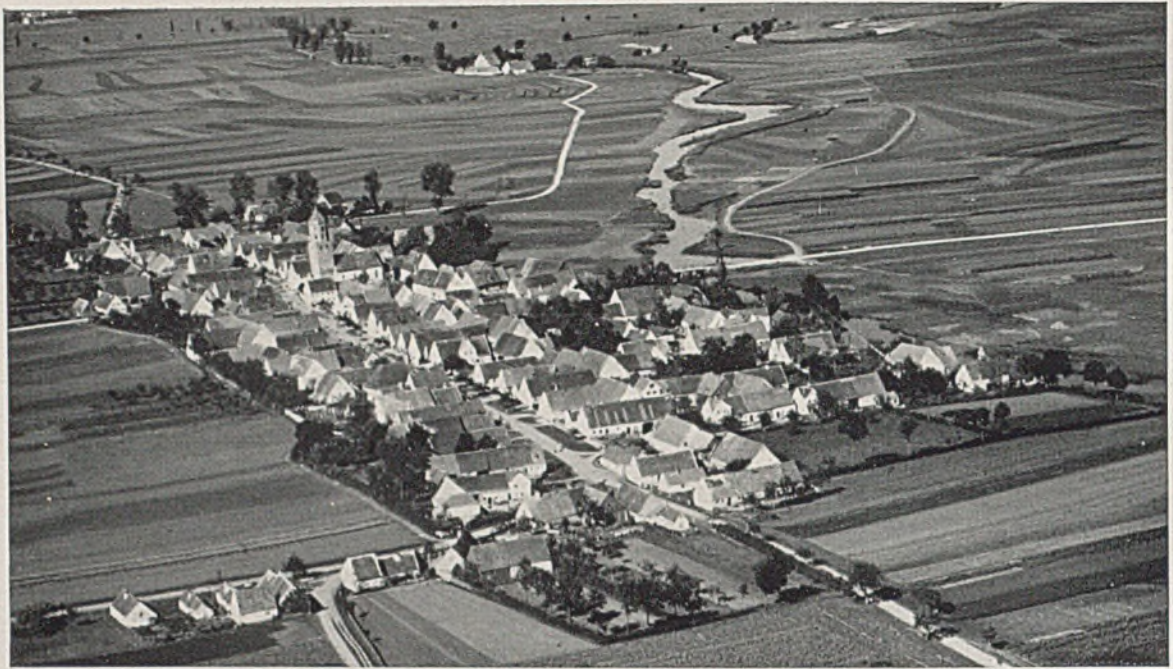
Straßendorf Munningen an der Wörnitz bei Nördlingen im Ries
