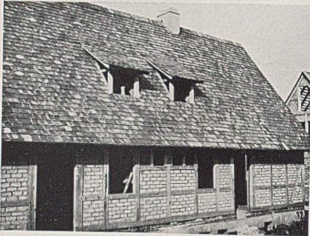
Links Doppelsiedlerstelle im Rohbau (Sontra II); rechts ein Volkswohnungsreihenhaus im hessischen Fachwerkbau
