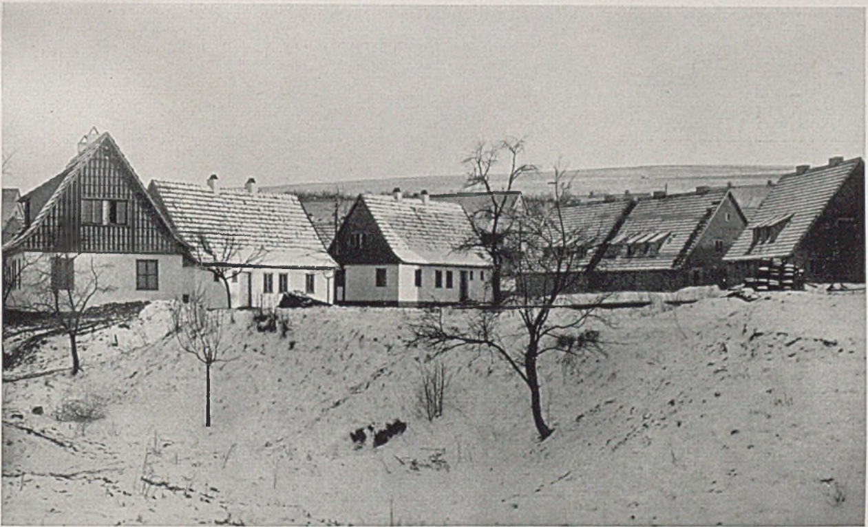
Aus dem Bauabschnitt Sontra I, Siedlungsbild hinter dem Gemeinschaftshaus
