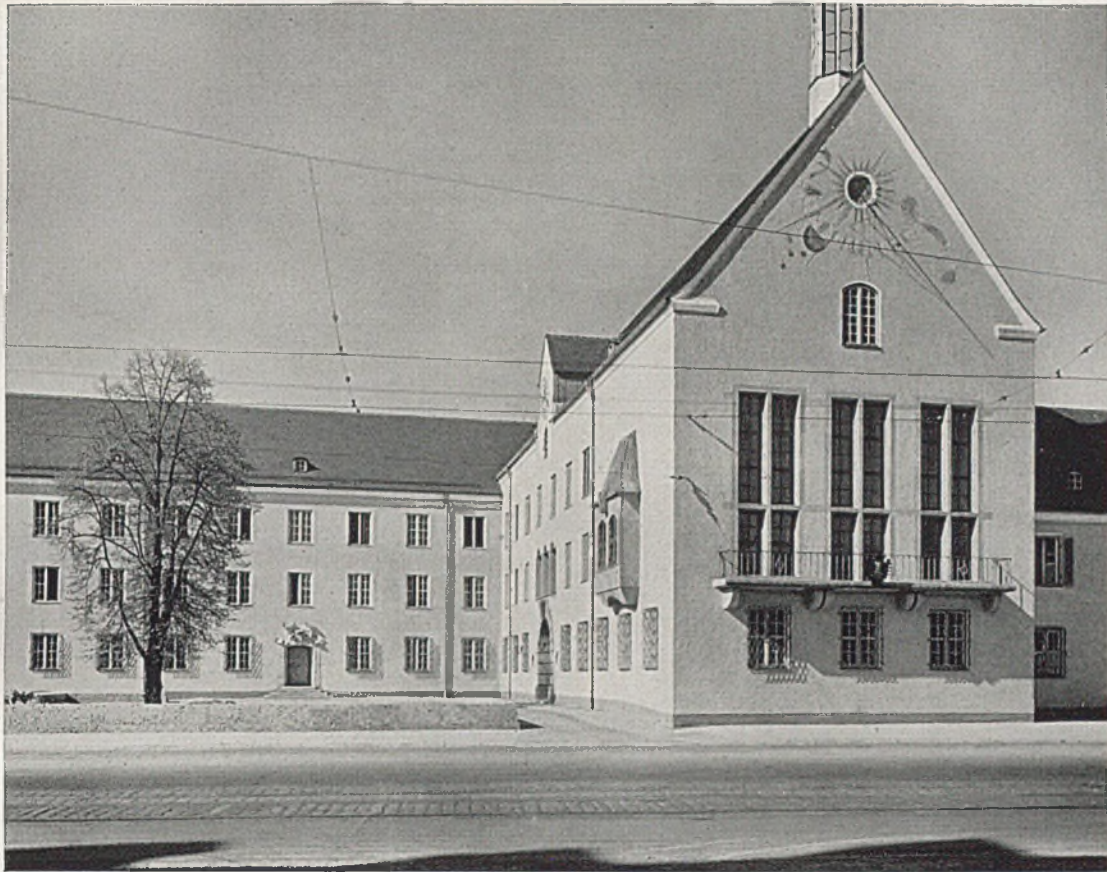
Blick von Süden (Münchener Straße) auf den Saalbau des Bezirksverwaltungsgebäudes
