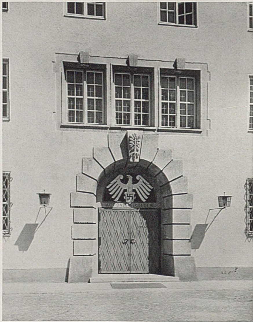
Haupteingang im Saalbau des Bez.-Verwalt.-Gebäudes mit Natursteinverkleidung Bildhauerarbeiten Osel - München-Pasing. Hoheitszeichen von Göhlert - Augsburg
