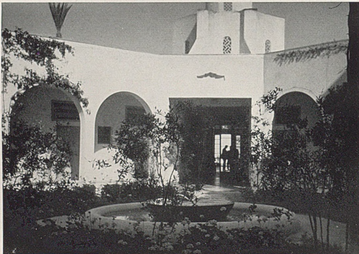
Albergo del Mehara, Tripoli d'Africa. Blick auf einen Wohnhof mit Kühle spendendem Wasserbecken
