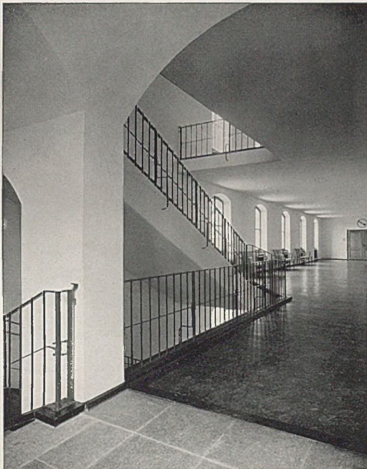
Vorhalle beim Saal im ersten Obergeschoß, Fußboden Korkparkett. Unten: Treppenhaus mit Blick in die Vorhalle beim Saal; Geländer Schmiedeeisen, rot gestrichen
