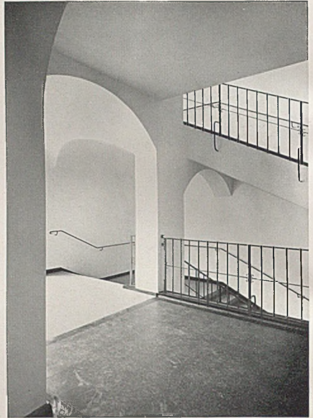
Blick in das Treppenhaus mit Geländeranschlüssen. Wangenabdeckung Schiefer. Fußboden Granit Unten Haupttreppenaustritt im zweiten Obergeschoß; links Bogen zum Flur des Verwaltungslügels
