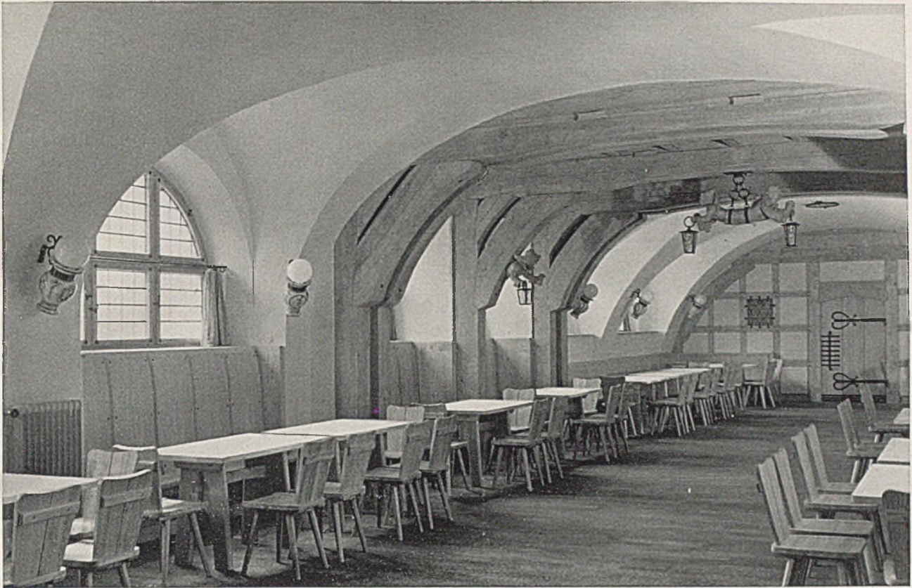
Umbau der Stiftshallen in Kempten. Möbel, Fenster und Türen in Lärche natur, Beschläge und Beleuchtungskörper Schmiedeeisen. Der Verputz des alten Gewölbes ist mit der Kelle glatt aufgetragen, gekalkt und zuletzt lasiert Unten: Holzbilder und Beleuchtungsträger: Bildhauer Gg. Gerber-Lindau
