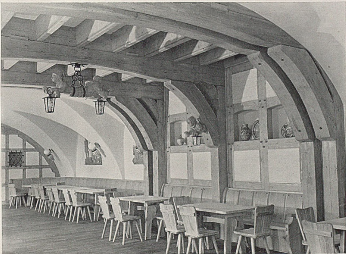
Umbau der Stiftshallen in Kempten. Möbel, Fenster und Türen in Lärche natur, Beschläge und Beleuchtungskörper Schmiedeeisen. Der Verputz des alten Gewölbes ist mit der Kelle glatt aufgetragen, gekalkt und zuletzt lasiert Unten: Holzbilder und Beleuchtungsträger: Bildhauer Gg. Gerber-Lindau
