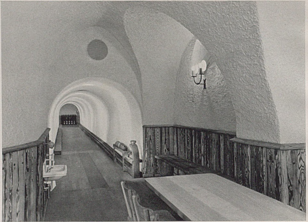
Die Bundeskegelbahn unter den Stiftshallen neben dem Luftschutzraum. Der Ansatz des alten Gewölbes ist gut zu sehen. In der niedrigen Kegelbahn ist „Schrankenbeleuchtung“, blendungsfrei und schattenlos, angeordnet.
