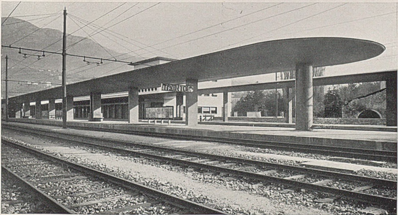
Empfangsgebäude des neuen Bahnhofs in Trento. Bahnsteige und Leitungsmasten
