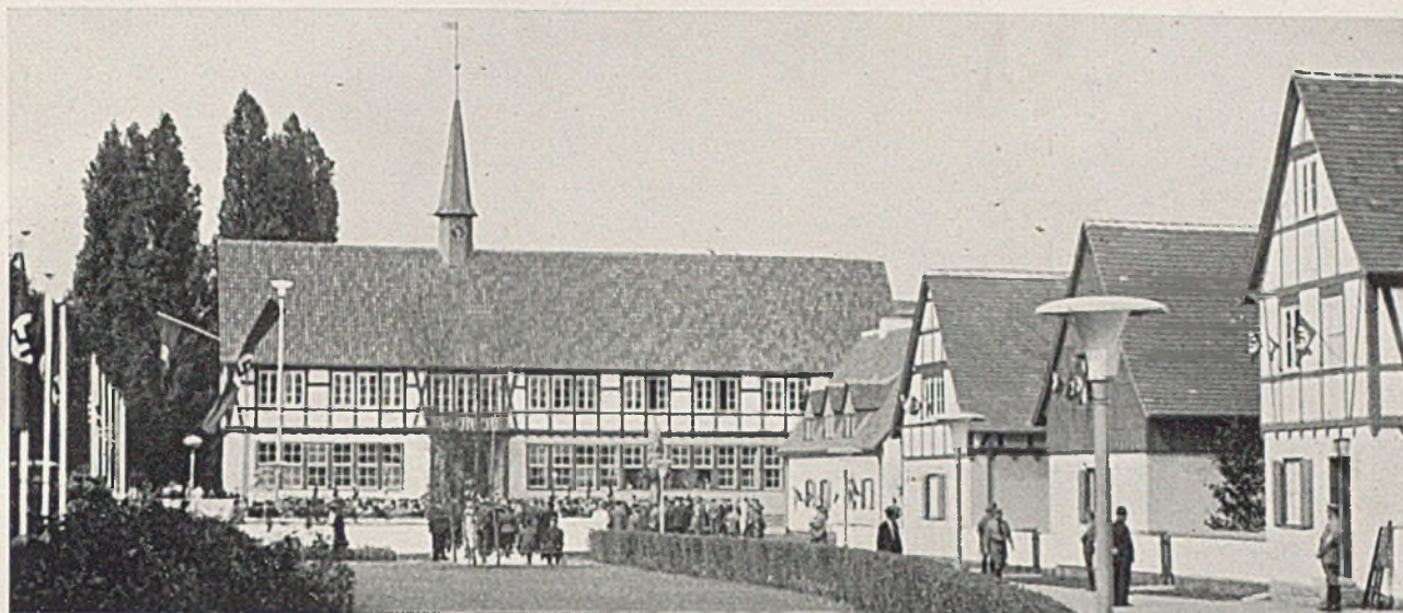
Das Gemeinschaftshaus „Zeppelinheim“ in der Ausstellungssiedlung des Gauheimstättenamtes Hessen-Nassau während der Eröffnungsansprache von Reichsorganisationsleiter Dr. Robert Ley, am 2. September 1938 Unten der Lageplan des Ausstellungsgeländes
