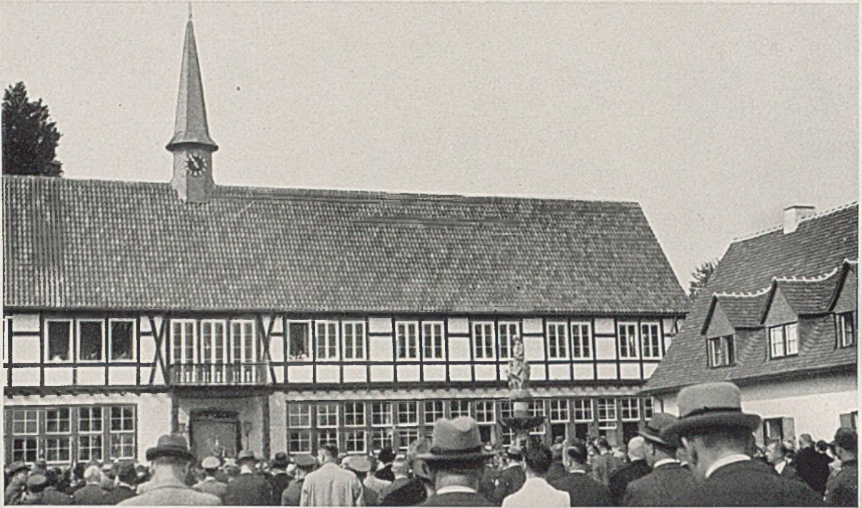
Der Gemeinschaftsplatz mit „Zeppelinheim“ und Brunnenplastik während der Eröffnungsansprachen
