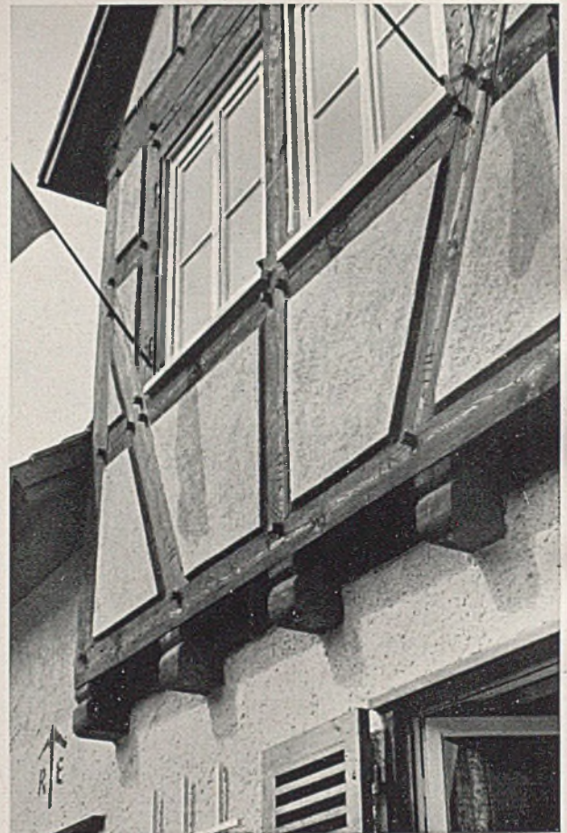
Bild rechts: Typ „Rheingau“; das Fachwerk am Erker
