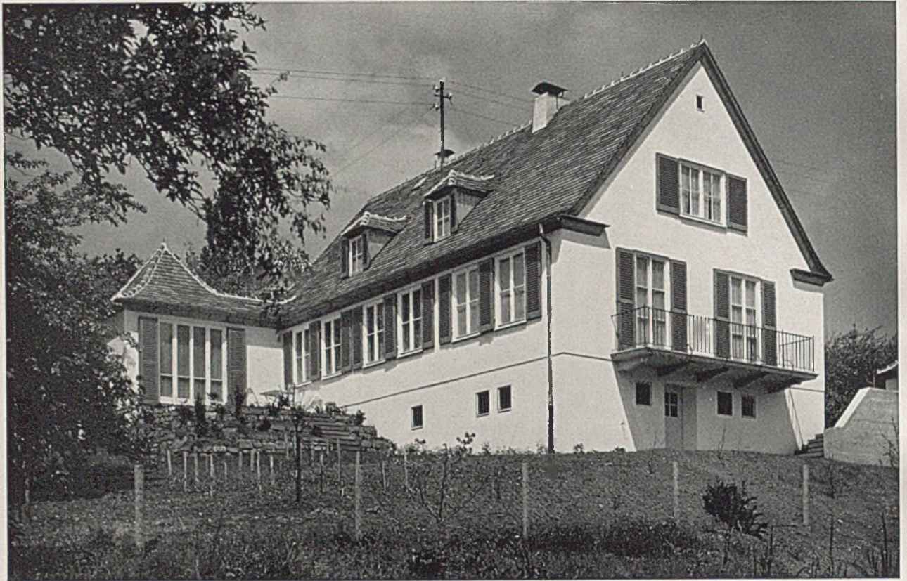
Einfamilienhaus Rieger in Vaihingen a. d. E. (Baujahr 1935). Blick vom Garten auf Gartenseite mit Gartenzimmer. Reine Baukosten etwa 21 500 RM.
