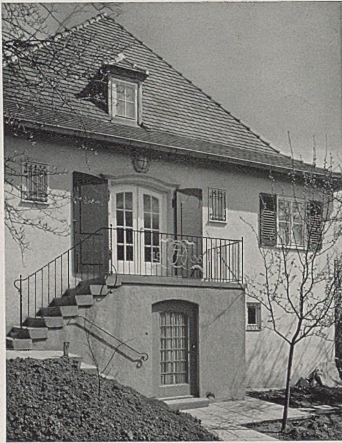
Einfamilienhaus Hink in Rohracker-Frauenkopf (1935/36). Die Gesamtbaukosten betragen einschließlich Architektenhonorar etwa 28000 RM. Am Südhang gelegen, Sockel Wabensteine, 30 cm stark, Obergeschoß Fachwerk verputzt.
