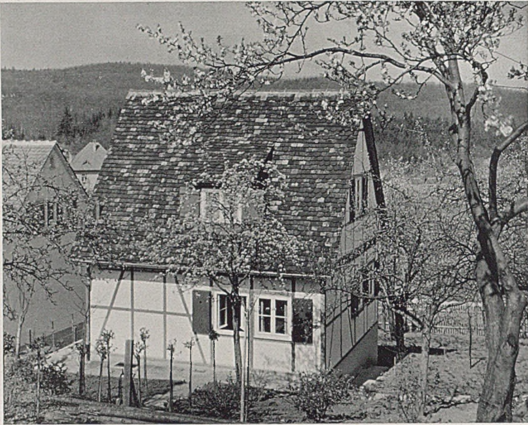
Einfamilienhaus Rampmaier in Stuttg.-Botnang (Baujahr 1934)
