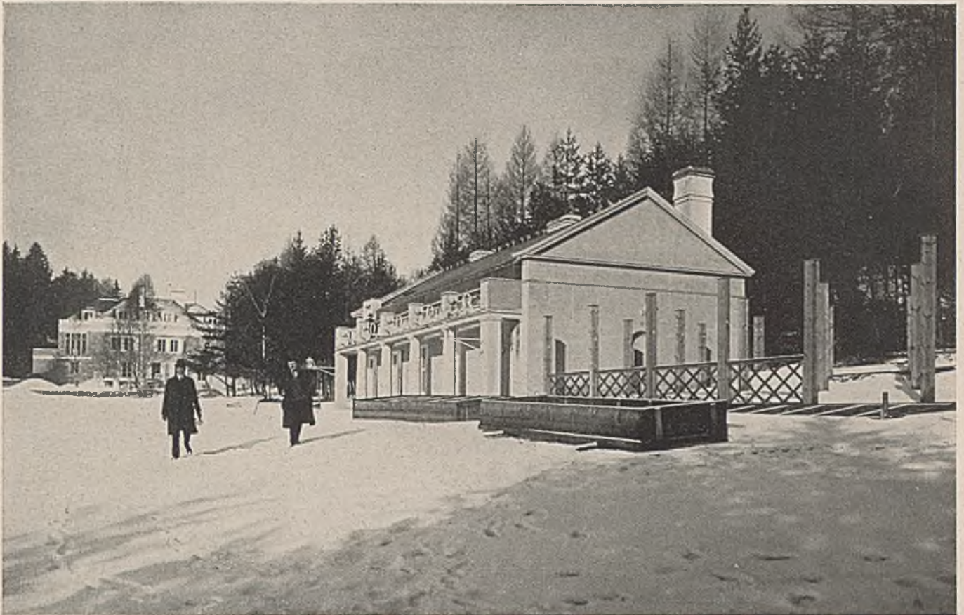
ARCH. PROF. OSKAR STRNAD - WIEN. »BLICK ZUM LANDHAUS UND GEWACHSHAUS«
