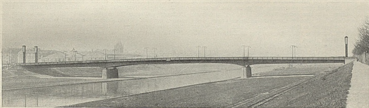
Abb. 1. Friedrich-Ebert-Brücke in Mannheim. (M. A. N. Gustavsburg.)
