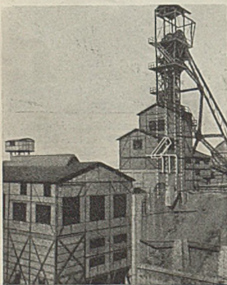
Abb. 6. Gerüst, Kippbunker und Separation der Kübelförderung der Polnischen Solvay-Werke, Grodziec. (Kübel in Entladestellung.)
