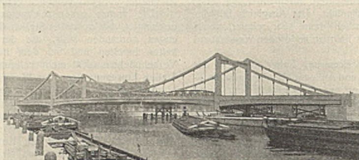
Abb. 1. Gesamtansicht der neuen Straßenbrücke über die neue Einfahrt zum Humboldthafen in Berlin.
