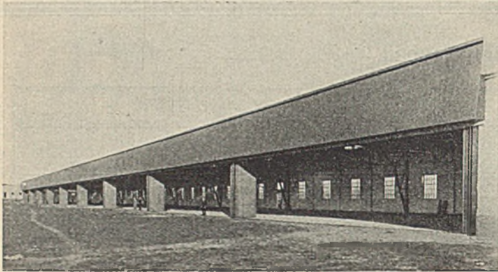
Abb. 4. Flugzeughallen Schneidemühl. (Außenansicht einer Halle.)
