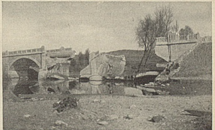
Abb. 2. Eisenbetonbrücke in km 146 + 800. Erbaut 1924, eingestürzt infolge Hochwassers im Herbst 1925.
