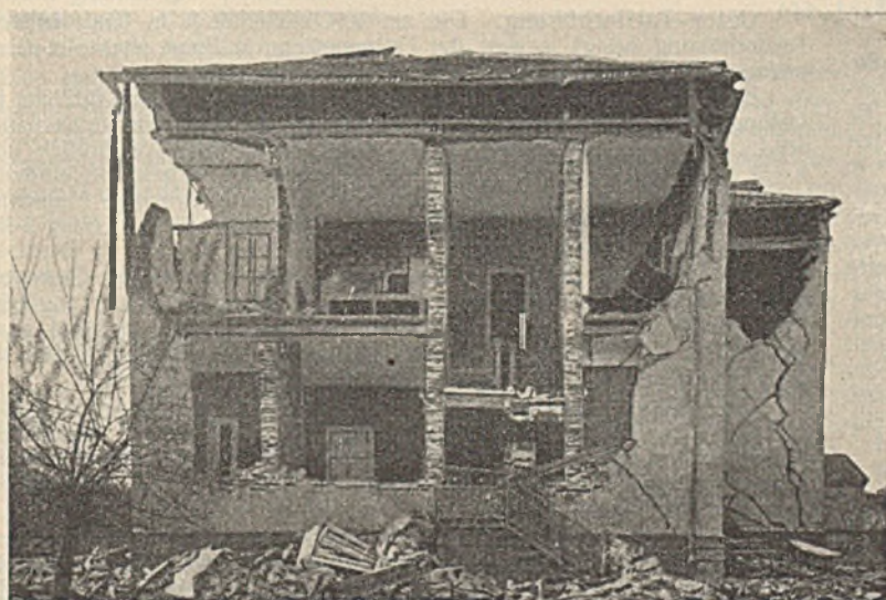
Abb. 4. Die zerstörte Landwirtschaftsschule in Sadovo.
