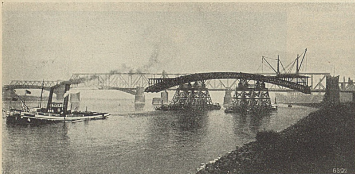
Abb. 3. Ausschwimmen der alten Überbauten.
