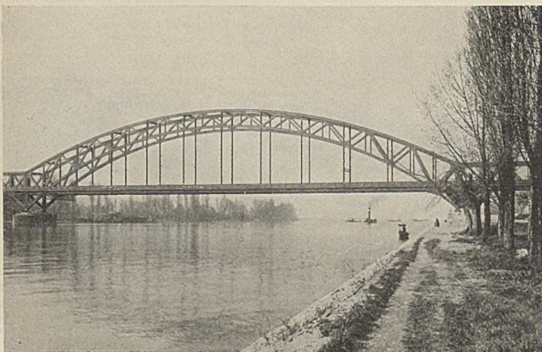
Abb. 23. Eisenbahnbrücke bei Rudesheim. (Teilaufnahme.)
