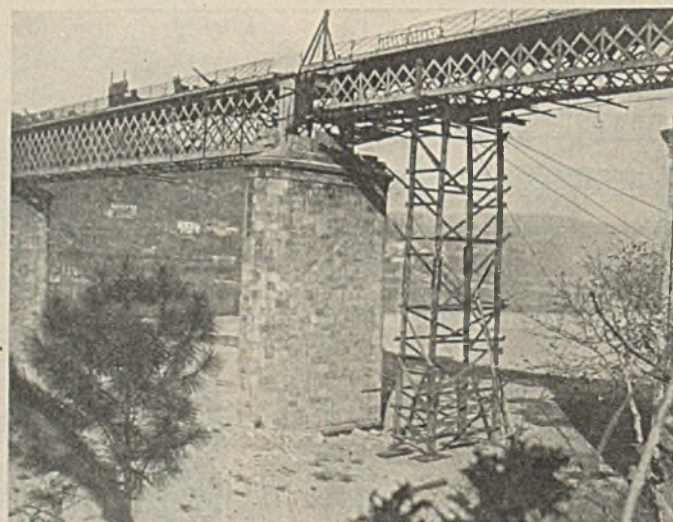
Abb. 9. Ansicht der in Wiederherstellung befindlichen Brücke.
