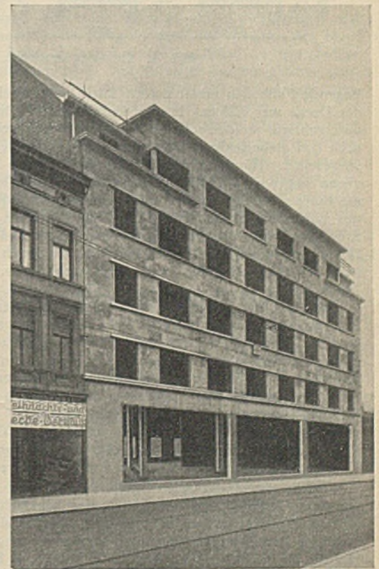
Abb. 2. Ansicht des fertigen Bauwerks mit ausgemauertem Stahlskelett.
