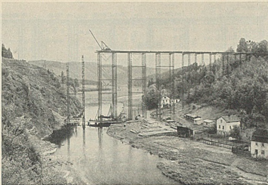
Abb. 3. Saalburger-Brücke, Aufstellung des Baugerüsts (Stand der Arbeiten Ende Mai 1928).
