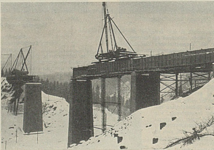
Abb. 2. Wettera-Brücke. Zusammenbau der Hauptträger.
