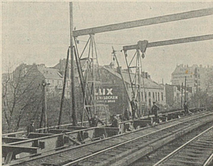
Abb. 26. Versetzen der Querträger mittels fahrbarer Portalkrane.
