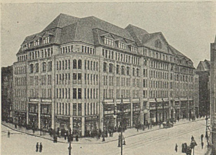
Abb. 16a. Ansicht nach der Fertigstellung.
