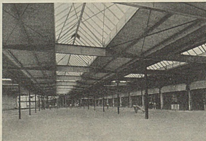
Abb. 3. Innenansicht der Hallen.
