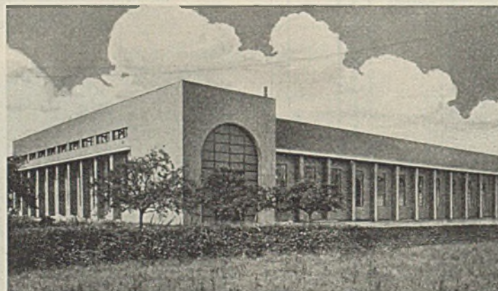
Abb. 3. Außenansicht der Montagehalle.
