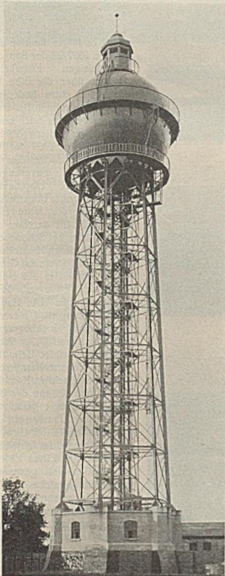
Abb. 7. Wasserturm von 500 m<sup>3</sup> Inhalt für die deutschen Solvay-Werke in Borth bei Buderich.
