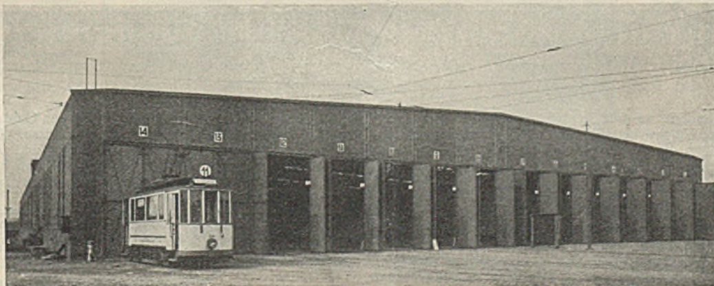
Abb. 1. Straßenbahn-Wagenhalle in Düsseldorf.
