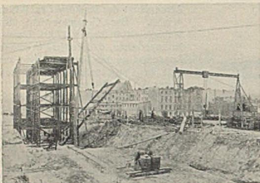
Abb. 10. Aufrichtung eines Rahmenfeldes.
