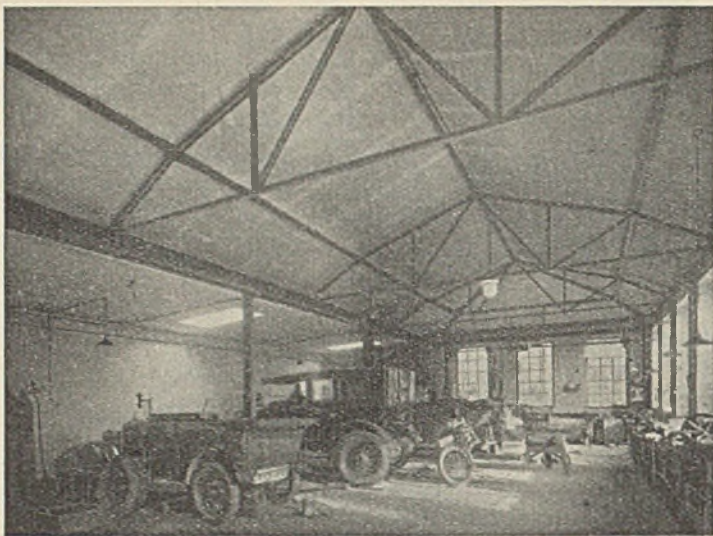
Abb. 1. Automobilhalle mit geschweißter Stahlkonstruktion.
