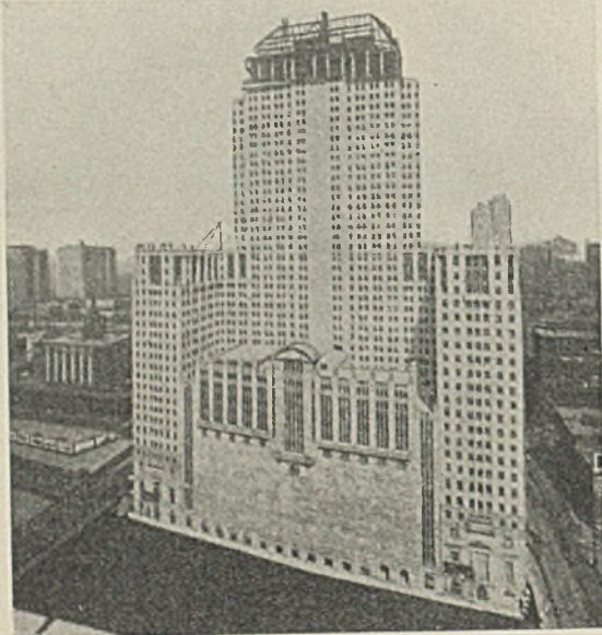
Abb. 1. Gesamtansicht des Gebäudes vom Flusse aus.
