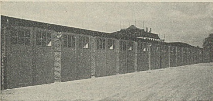
Abb. 7. Stahltüren einer Autogroßgarage.
