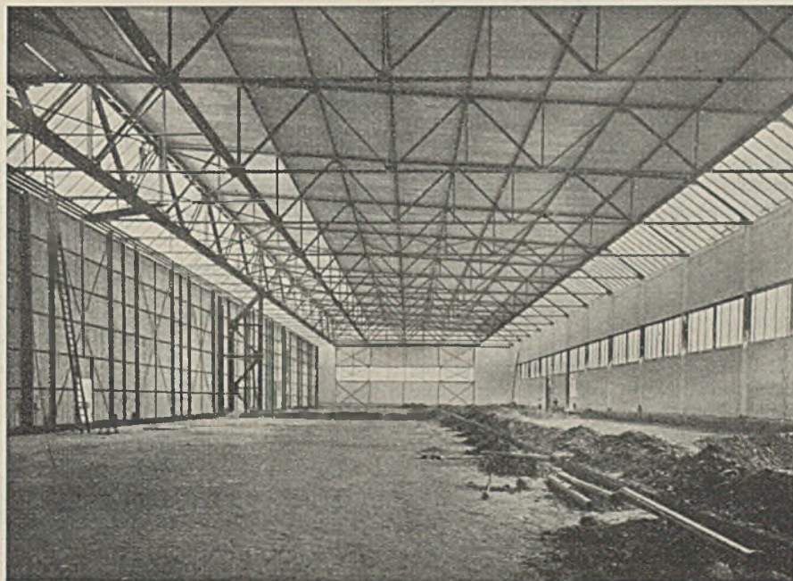
Abb. 5. Innenansicht der Halle.
