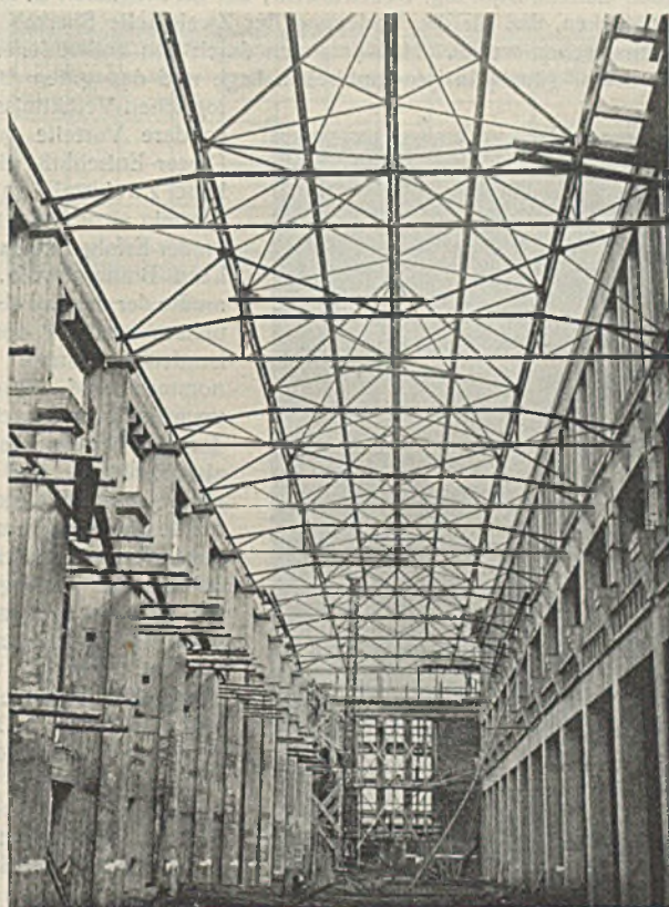
Abb. 12. In Österreich geschweißtes Fabrikhallendach, 12 m Spannweite.
