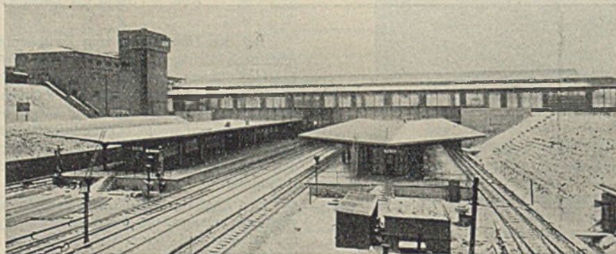
Abb. 2. Blick auf die Gesamtanlage.
