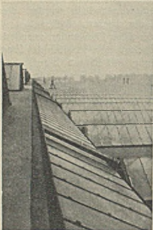
Abb. 15. Blick auf das Sattel-Glasdach. (Giebelleisten.)
