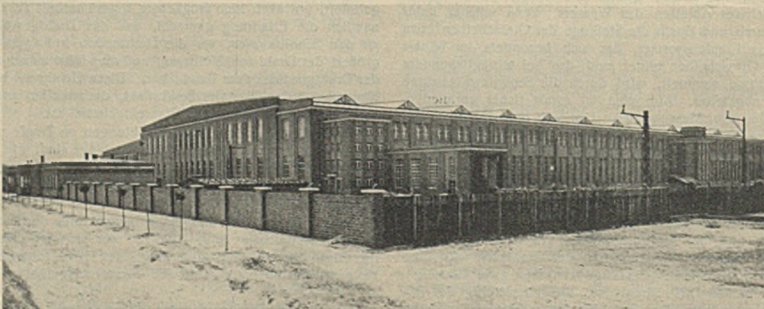
Abb. 21. Die neue Halle für elektrische Lokomotiven in Dessau.
