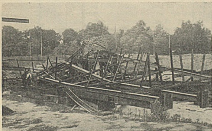
Abb. 13. Die umgekippten Stützen mit Fußplatten.
