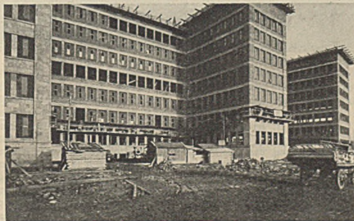
Abb. 10. Kurz vor der Beendigung der Ausfachung.
