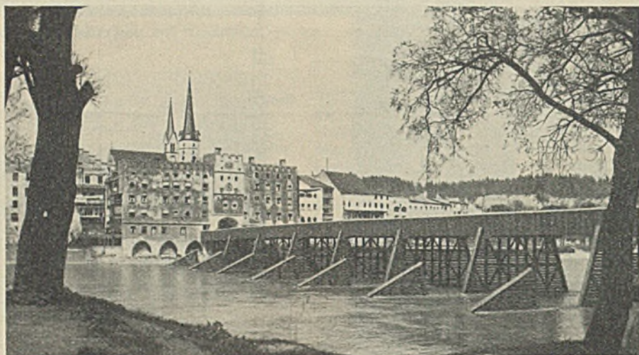
Abb. 9. Blick auf die neue Brücke mit Eisbrechern.
