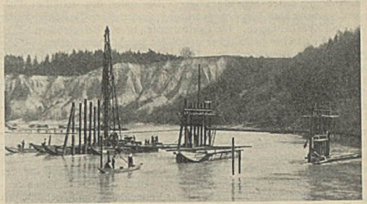
Abb. 7. Schwimmende Ramme bei der Arbeit.
