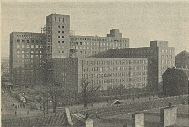
Abb. 10. Das Wernerwerk nach der Ausfachung.
