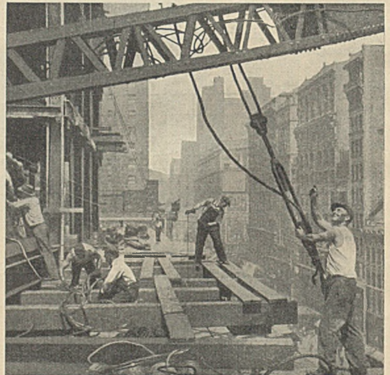
Abb. 3. Auskragende Plattform für den Aufzugskran.
