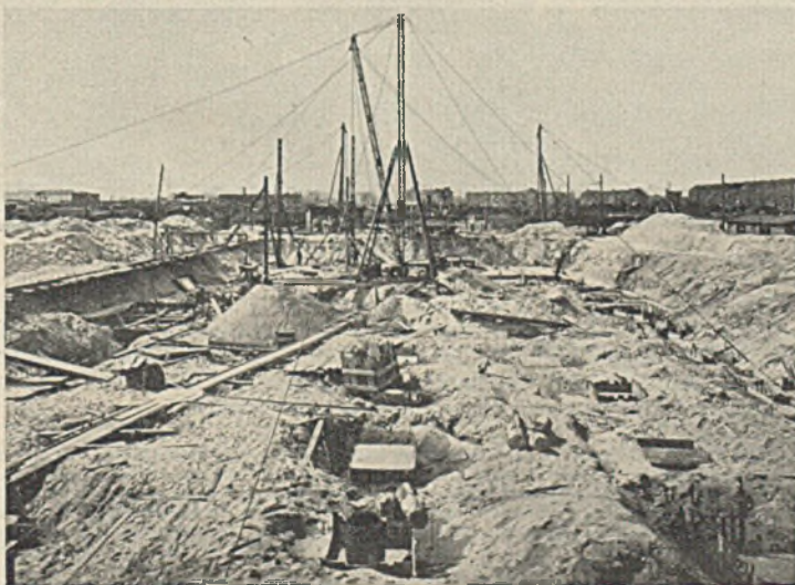
Abb. 3. Baustelle am 21. Juli 1930.
