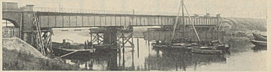
Abb. 22. Auswechslung der Eisenbahnbrücke über die Bille; der letzte Hauptträger wird hochgezogen.
