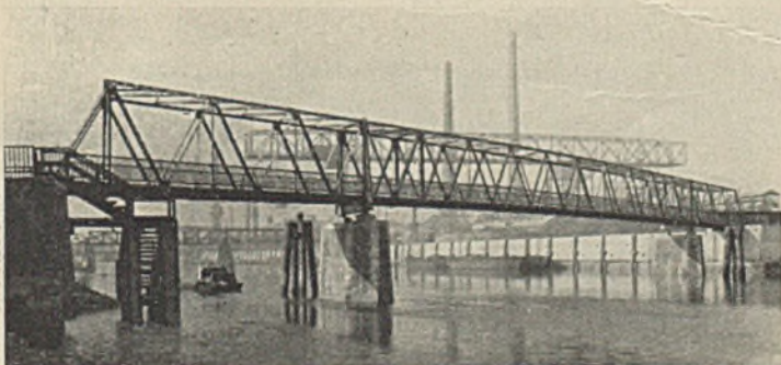
Abb. 10. Ansicht der fertiggestellten Brücke.
