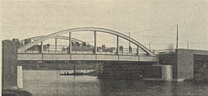
Abb. 20. Billekanal-Brücke im Zuge der Großmannstraße.
