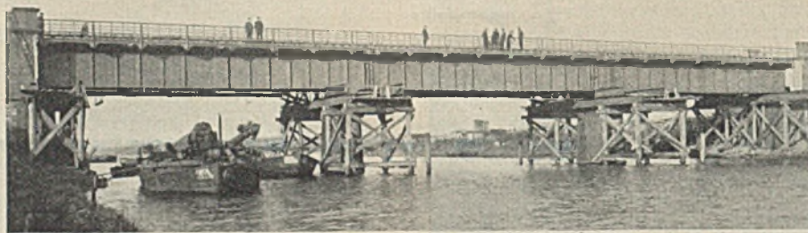
Abb. 25. Die neue Eisenbahnbrücke über die Bille ist eingefahren.
