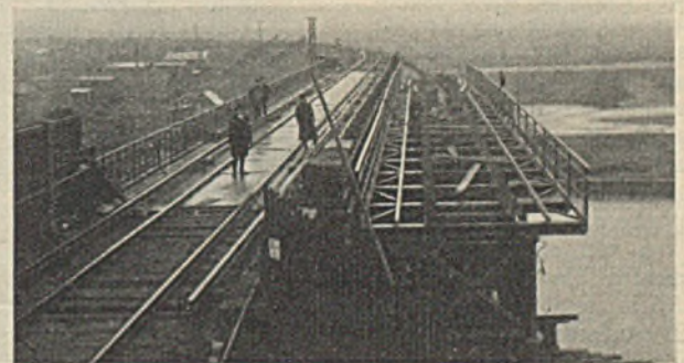
Abb. 23. Die Brücken vor der Auswechslung.
