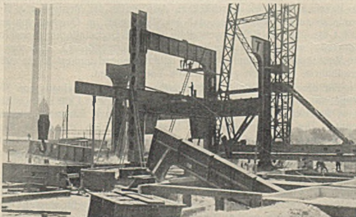
Abb. 17. Querrahmen mit Gelenk an der Mittelstütze. 14. Juli 1929.
