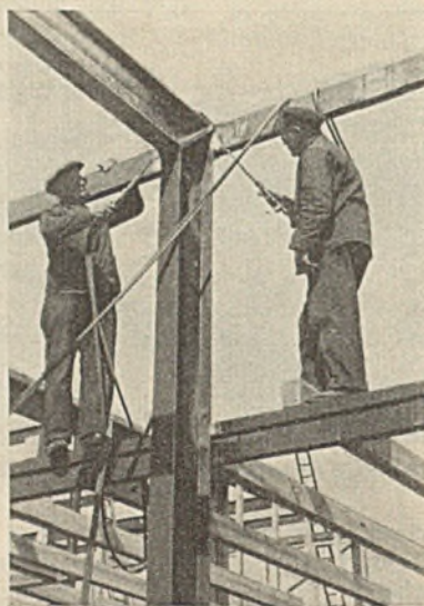
Abb. 6. Anschweißen der Traufpfette.
