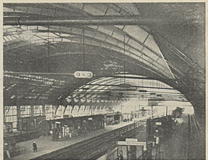
Abb. 3. Nördliche Bahnsteighalle Schlesischer Bahnhof nach teilweiser Erneuerung (Hallen-Mittelstück zeigt noch die alte Dachkonstruktion).
