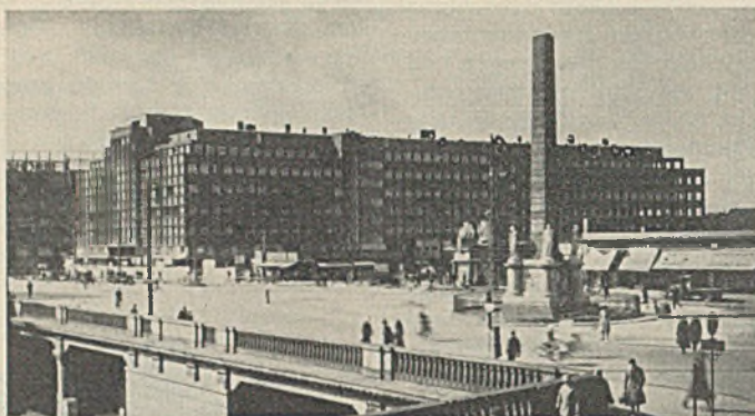
Abb. 20. Geschäftshaus Vesterport, Kopenhagen, der erste Stahlskelettbau Dänemarks.
