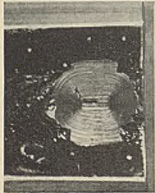
Abb. 4. Mangelhafter Einbrand und fehlende Einschweißung an der Nahtwurzel.
