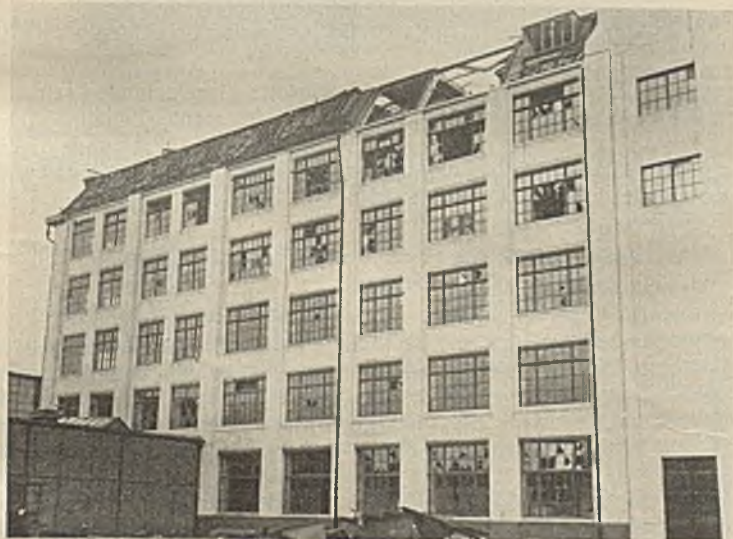
Abb. 3. Außenansicht der Längswand.
