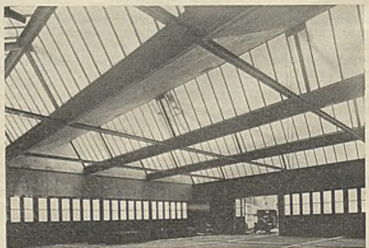
Abb. 5. Blick in die Halle.
