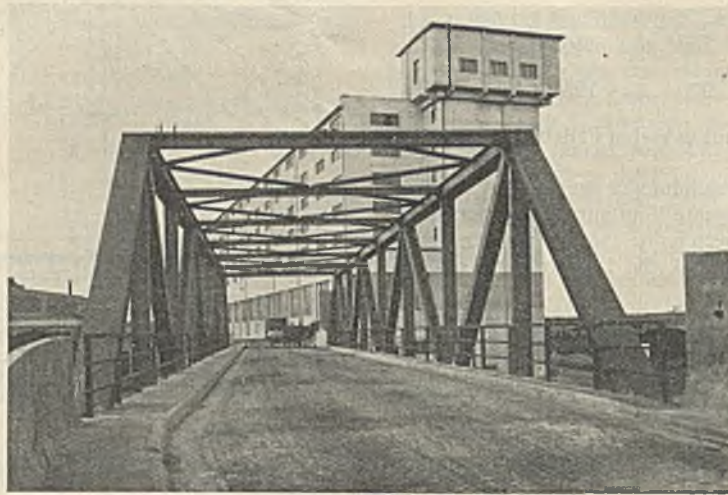
Abb. 6. Blick in die fertige Brücke.
