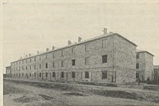
Abb. 10. Ansicht der unverputzten Wohnhäuser.
