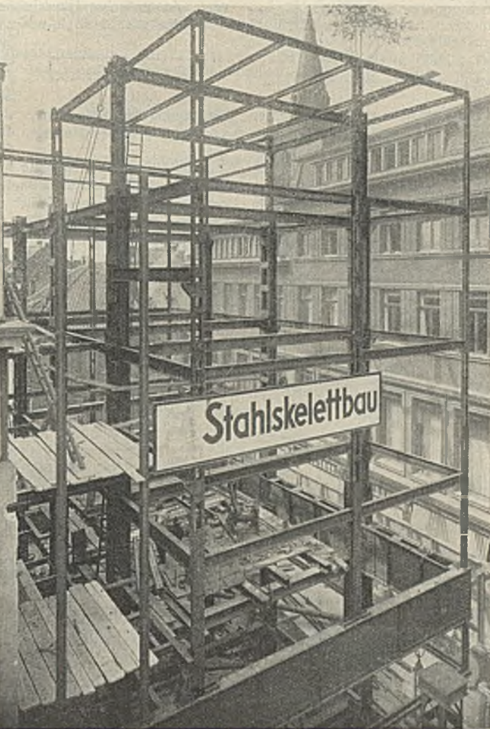
Abb. 7. Stahlskelett nach beendeter Montage von der Hochstraße her gesehen.
