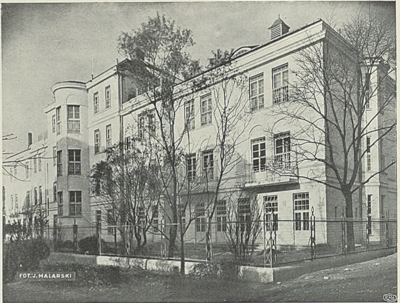
Rys. 5. Arch. Władysław Borawski (Warszawa). Szpital św. Stanisława. Widok tylny pawilonu obserwacyjno-zakaźnego.
