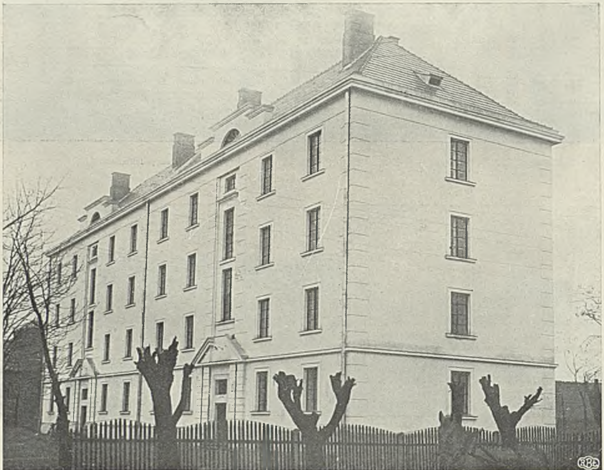
Rys. 20. Arch. Tadeusz Obmiński i Artur Korytkowski. Dom oficerski dla 16 rodzin w Chełmie. 16 (3 P + K) = 64 izb. Pow. zabudowy — 451,26 m 2 . Kubatura 6633,52 m 3 . Pow. mieszkań — 16 × 64,40 = 1030,40 m 2 . Budowę wyk. firma „Paszkowski i Próchnicki” (Warszawa).
