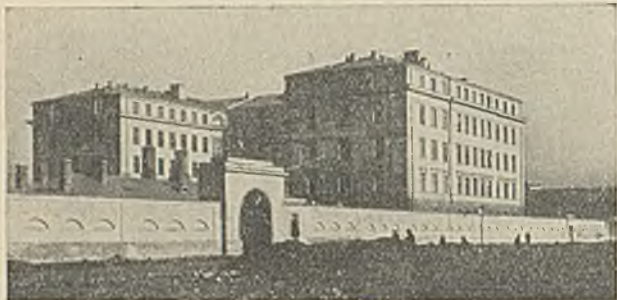
Fragment Oficerskiej Szkoły Inżynieryjnej. Budowa wykonana przez firmę „Żelazo-beton“
