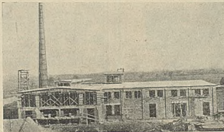
Budowa hali żelbetonowej dla Fabryki Szamotów w Skawinie (1.700 m 2 zabud. powierzchni).
