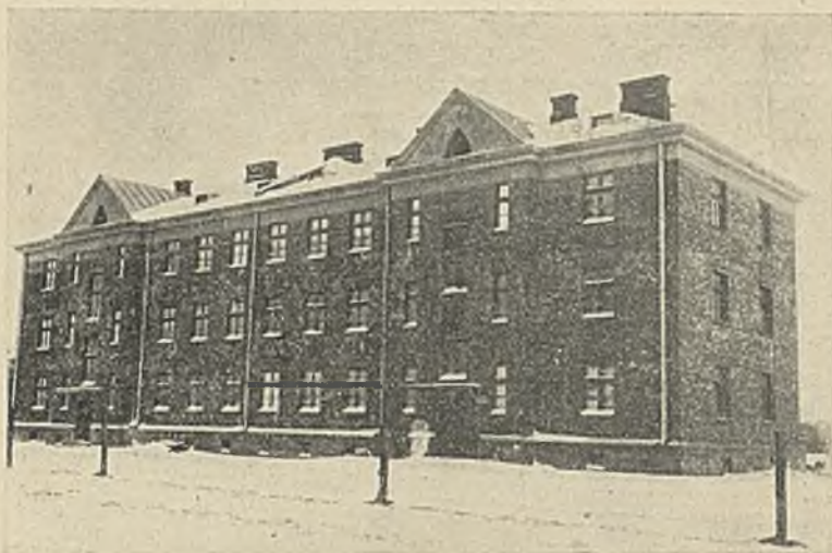
Dom dla podoficerów w Kutnie proj. arch. W. Polkowski. wyk. Towarzystwo Przemysłowo-Budowlane „BUDOPOL” w Warszawie
