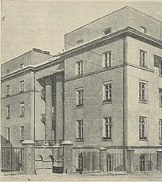
Dom dla oficerów przy ul. Gródeckiej we Lwowie. Proj. arch. inż. Rudolf Indruch—Wyk. firma H. Zaremba i S-ka, we Lwowie.
