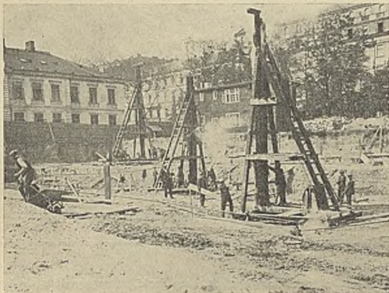
Fundamentowanie gmachu Banku Gospodarstwa Krajowego w Warszawie.
